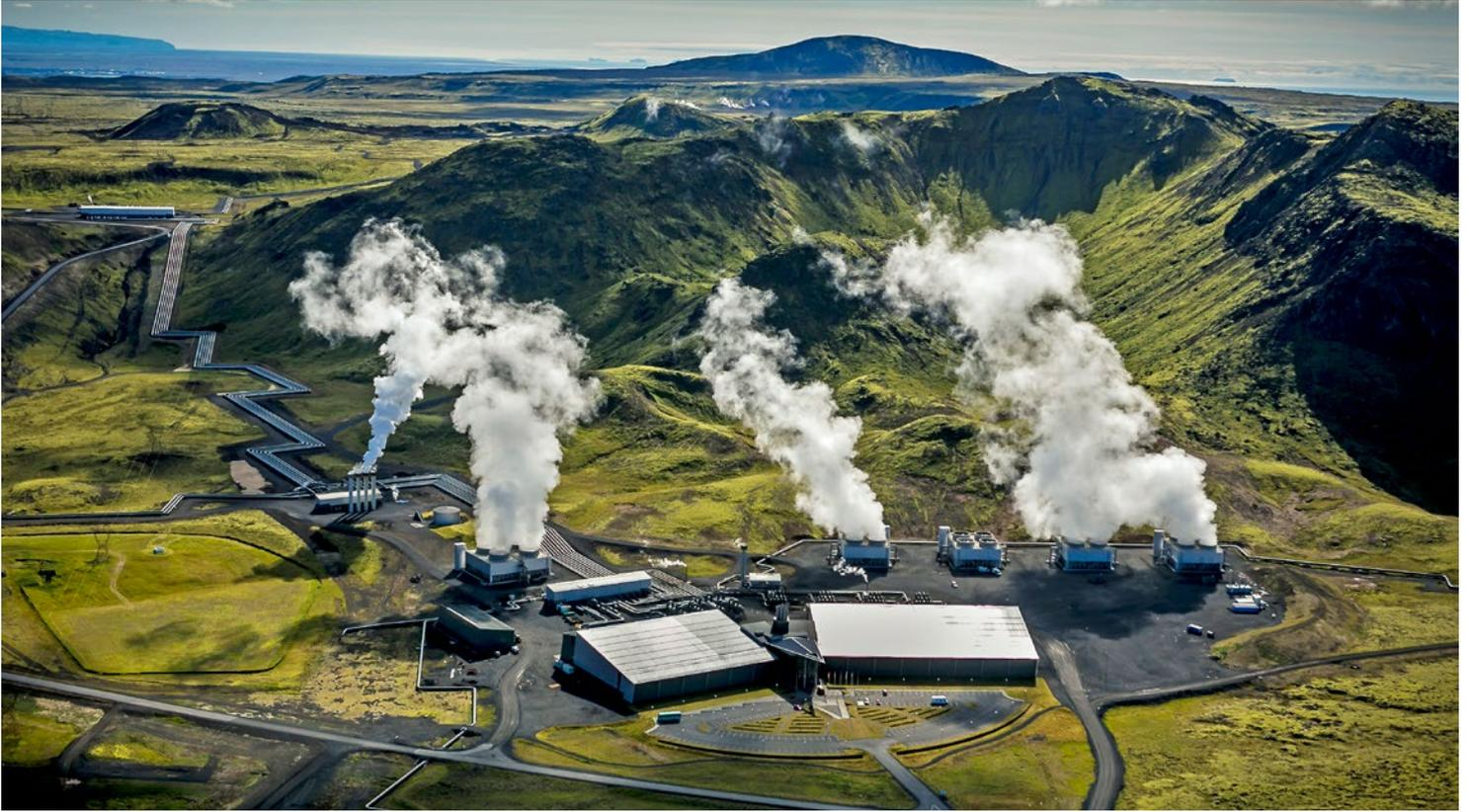
boration avec le projet de recherche européen CarbFix. Sur l'île de l'Atlantique Nord, le CO<sub>2</sub> est filtré à partir de l'air, mélangé à de l'eau, puis pompé dans des cavernes de basalte souterraines. Après une réaction chimique, le gaz carbonique se dépose sous forme de carbonate et forme du calcaire, pour ainsi dire, un stockage final sûr pour l'éternité. Grâce aux sources chaudes, l'Islande dispose également de suffisamment d'énergie propre pour aspirer l'air de l'atmosphère.
